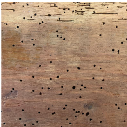
24. Stuccatura con balsite (prima)
