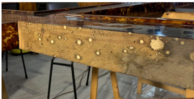
20. Rimozione meccanica (prima)
