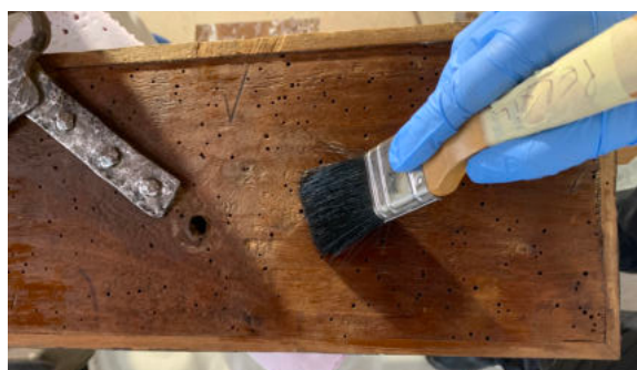
23. Intervento di consolidamento a pennello
