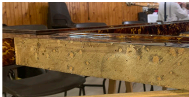
20. Rimozione meccanica (dopo)
